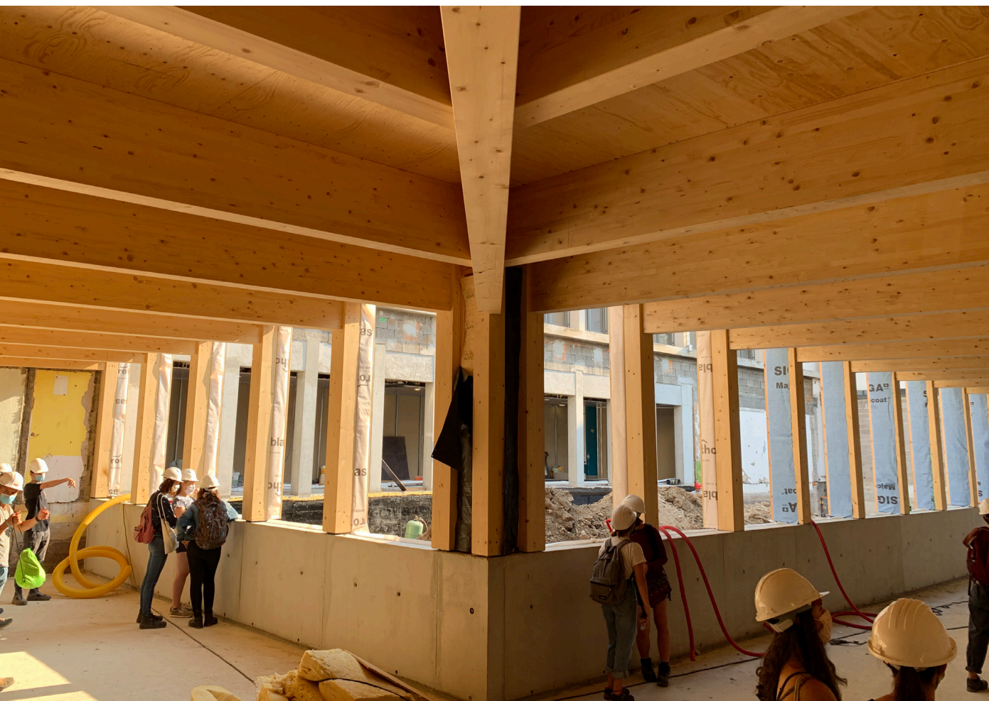
• Visite de chantier – 2020
